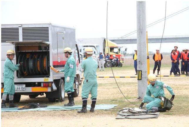
配電線復旧訓練
