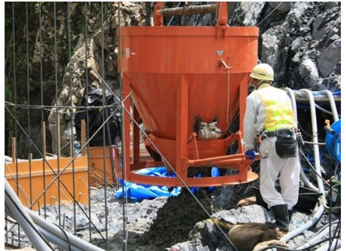
写真—3 初打設コンクリート 放出
