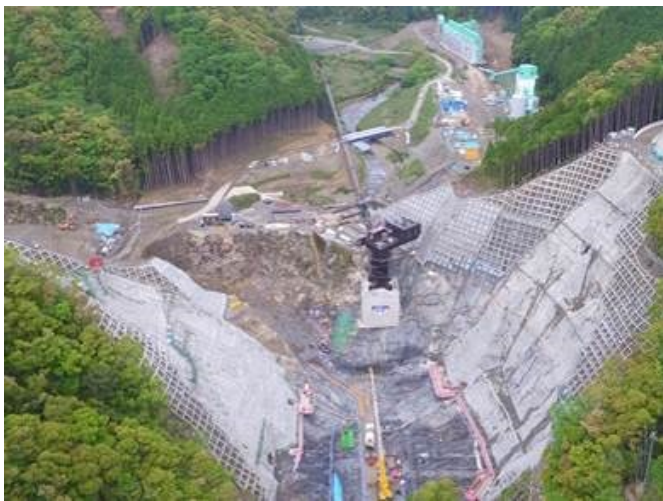
写真—1 横瀬川ダムサイト 全景
