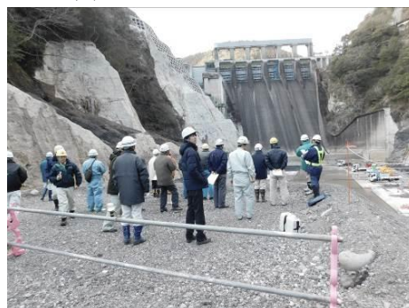
「長安ロダム施設改造工事」現場見学会
