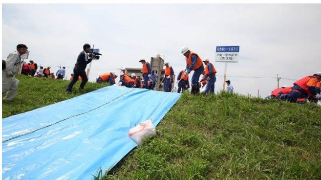
応急型シート張り工
