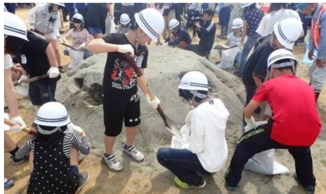
準備工（小学生による土のう作り）
