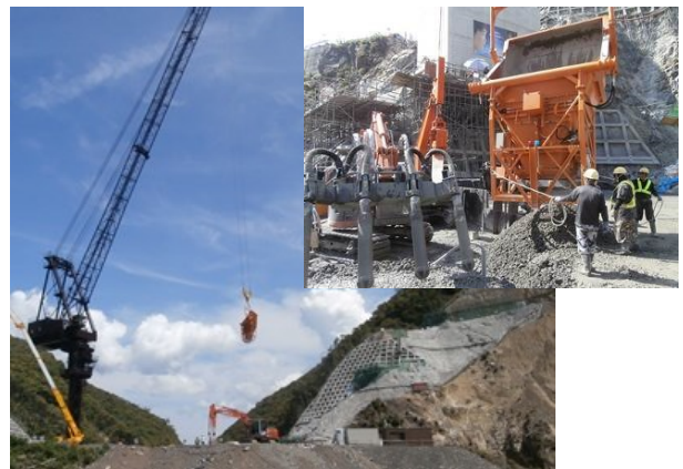
写真—8 コンクリート運搬、打設設備
