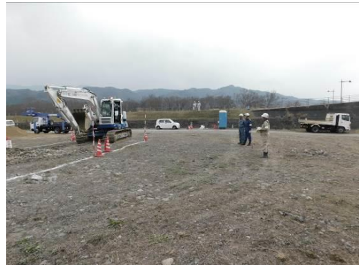
遠隔操縦式バックホウ操作訓練
