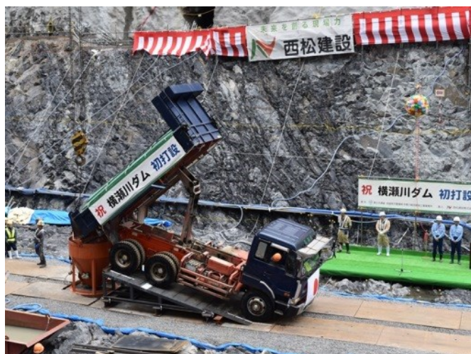
写真—2 初打設コンクリート バケット投入
