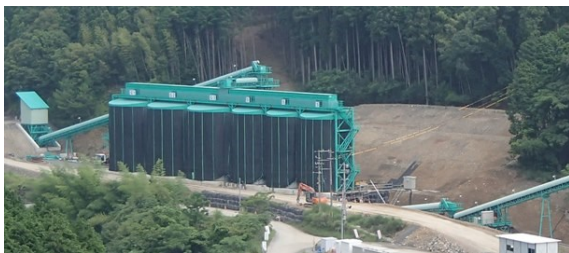
写真—6 骨材貯蔵輸送設備
