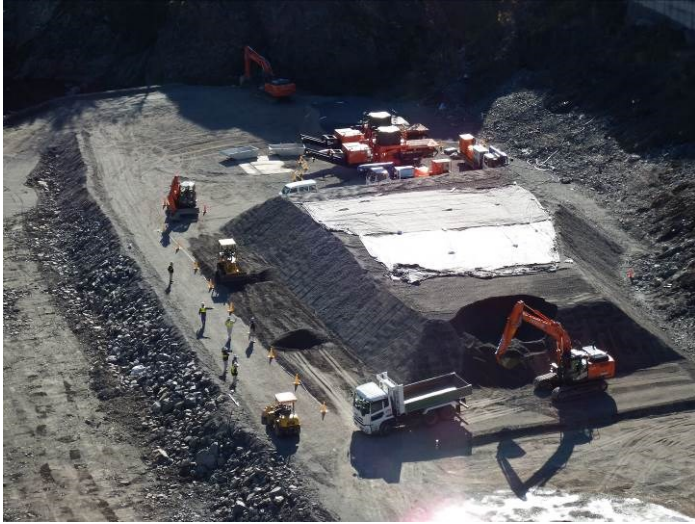
写真—8 CSG 資材ヤード施工状況
