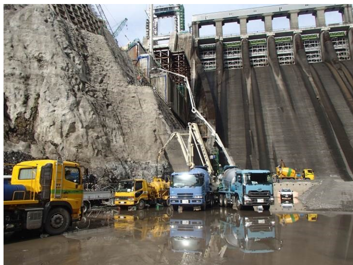
写真-7 導流水路打設状況
