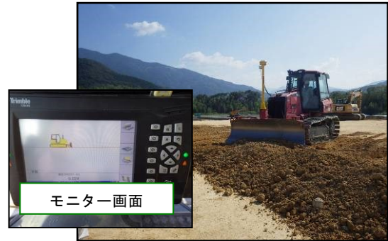
ICTブルドーザによる敷均し
