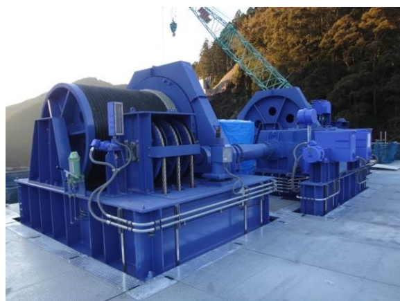
写真－5 開閉装置据付状況
