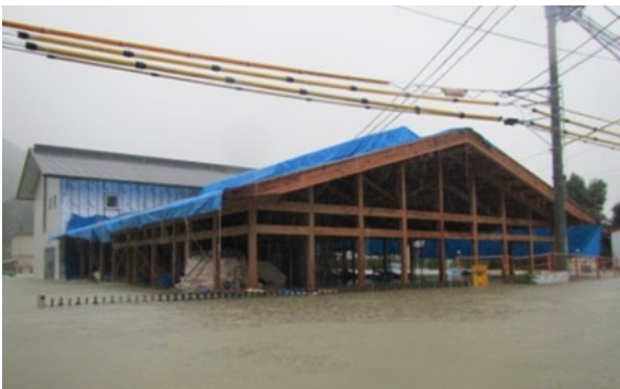
①完成前の「村の駅ひだか」浸水状況
