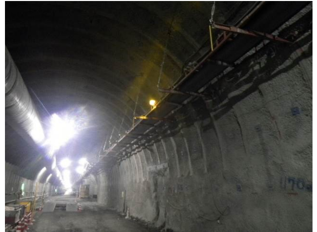
写真-5 掘削部連続ベルトコンベヤ稼働状況
