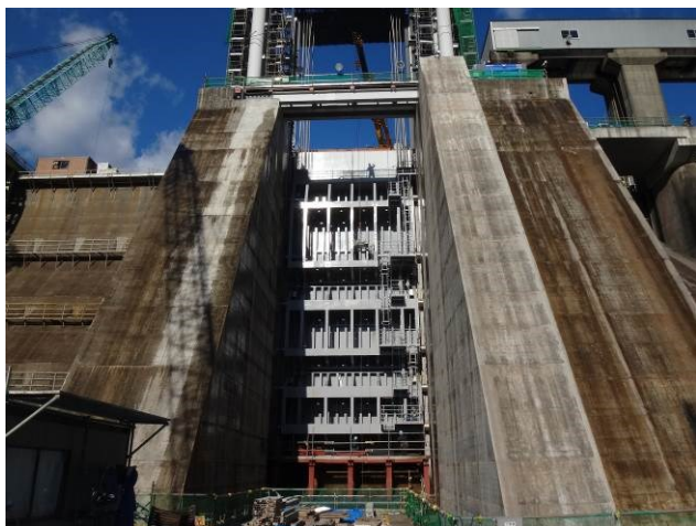
写真－2 可動ゲート設置状況
