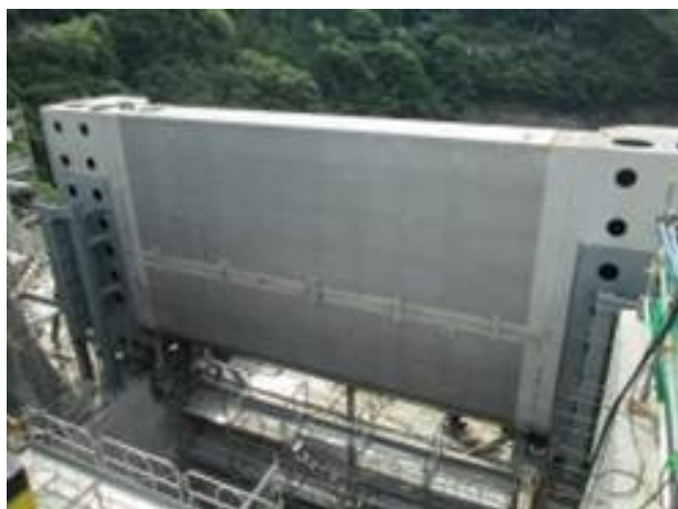
写真－1 固定ゲート設置状況
