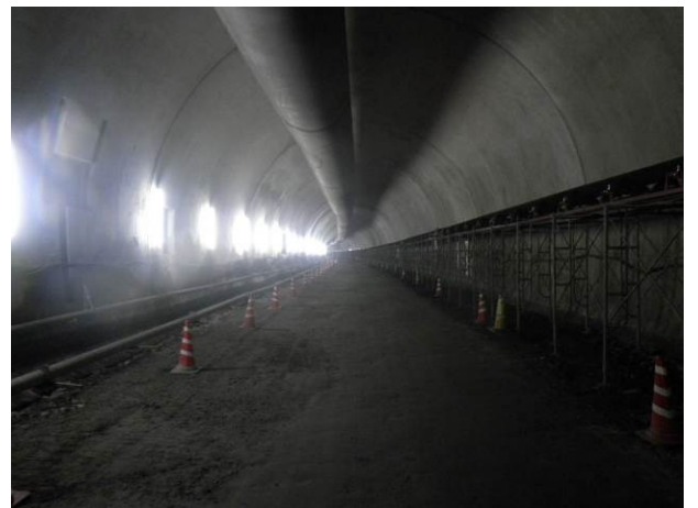
写真-6 覆工部連続ベルコン稼働状況
