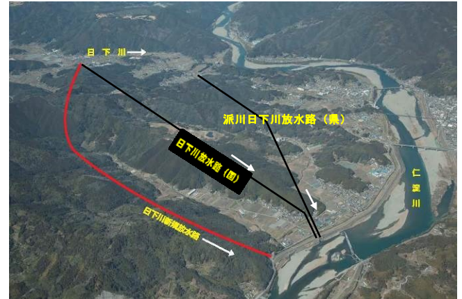
写真-1 日下川新規放水路
