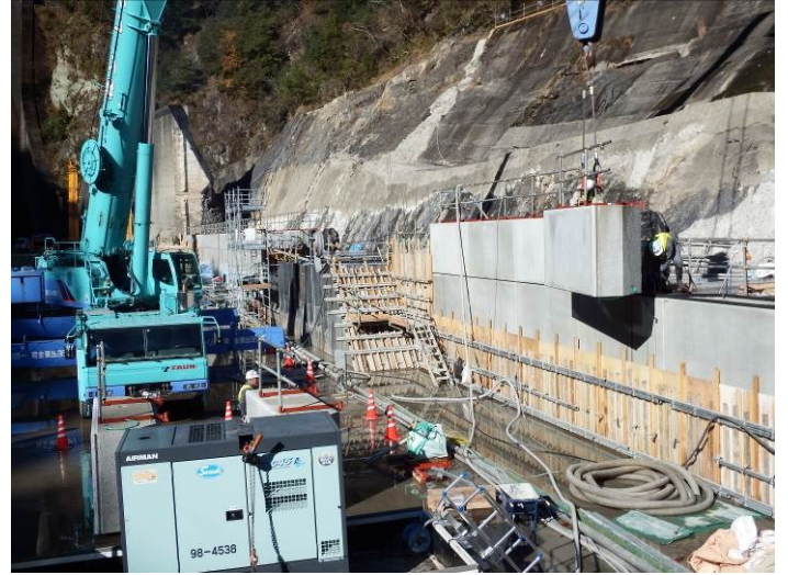
写真—9 減勢工側壁部施工状況
