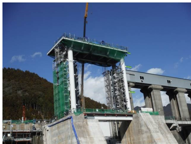
写真－4 鋼製門構据付状況
