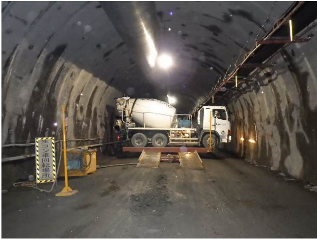
写真-3 ターンテーブル使用状況
