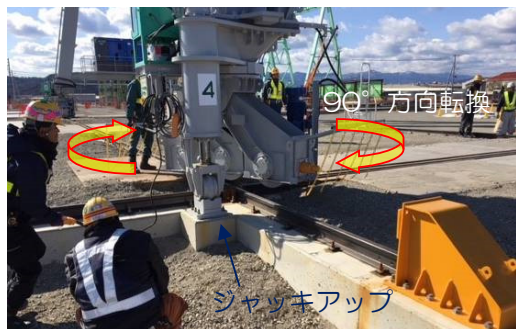
写真-4 走行装置転換状況
