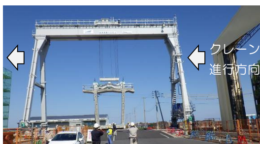
写真-3 セグメントの道路横断状況
