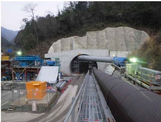
写真-1 新猪ノ鼻トンネル(香川県側)
