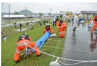
シート張り工
