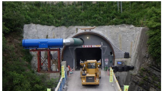
写真-3 新猪ノ鼻トンネル(徳島県側) ベッセルダンプによるズリ搬出状況
