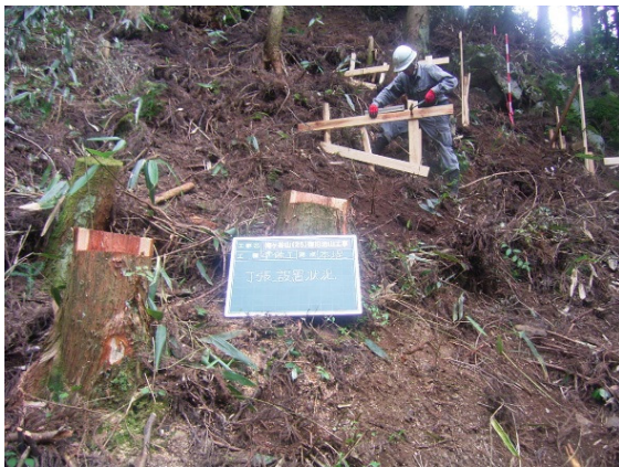
写真-3 高所での丁張設置状況(従来工事)
