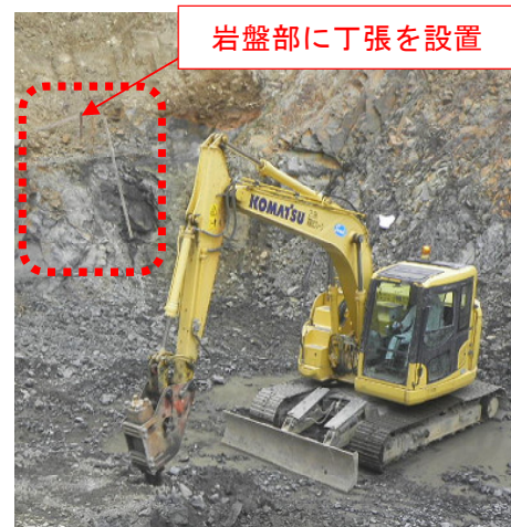
写真-5 岩盤部での丁張の設置
