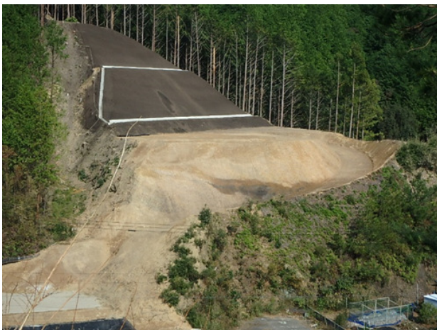
切土工区完成写真
