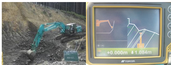
写真-4 掘削状況とモニター画面の例
