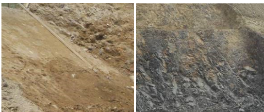
写真-6 土砂(左)と岩(右)の法面の掘削面の状況
