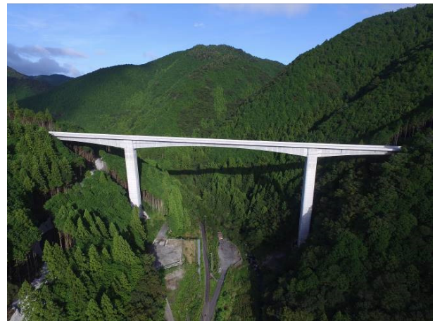
《市野瀬橋 橋長 264m 桁下高最大約 80m》
