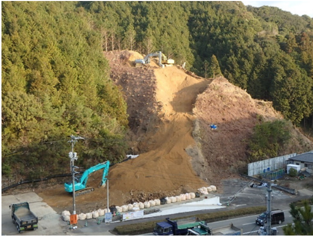
ICT 建機による施工（最上部）
