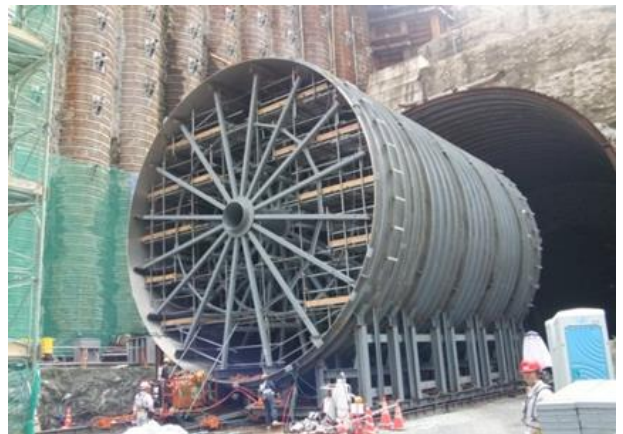
写真-4 水圧鉄管の水平ジャッキによるスライド状況
