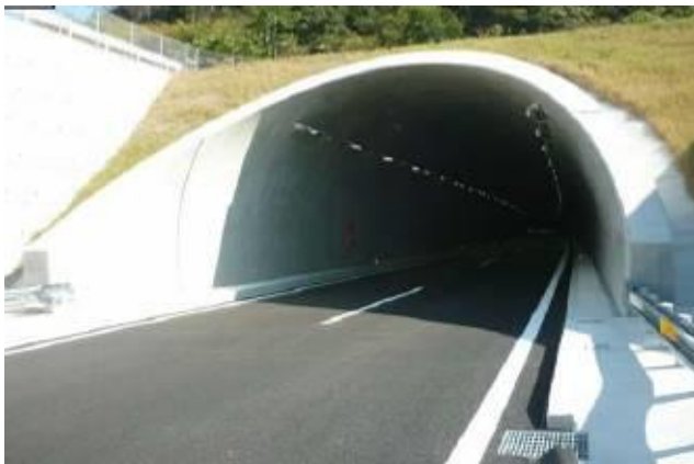
《志度トンネル(上り線)坑口》
