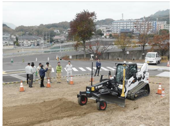
小規模土工用建設機械実習
