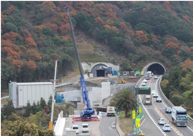
《トンネル施工状況》
