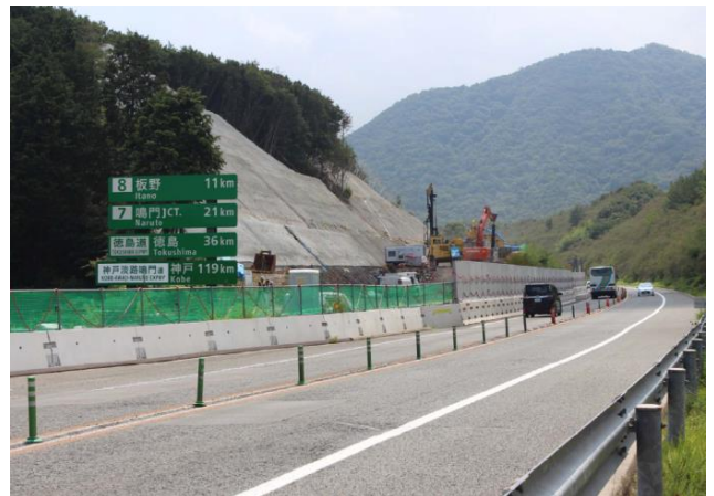
《切土施工状況》
