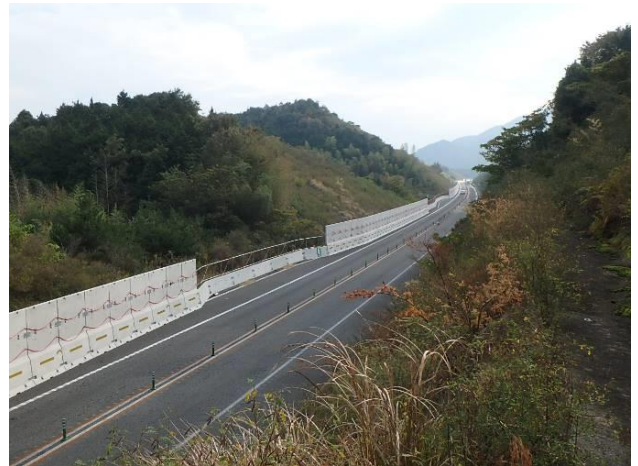
《仮設防護柵設置状況》
