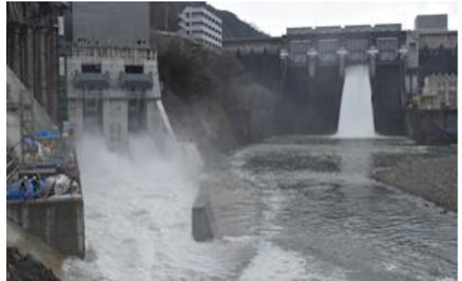
写真-6 トンネル洪水吐放流状況
