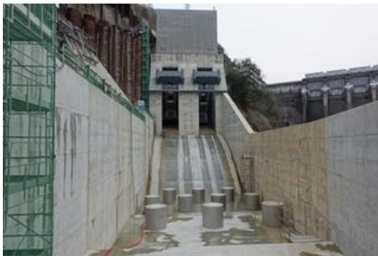
写真-5 減勢工シュート部
