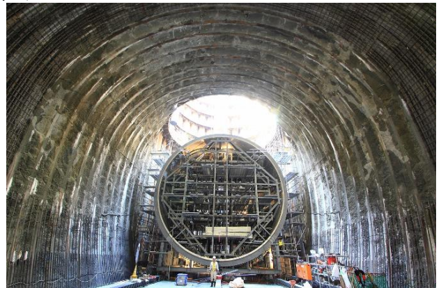
写真-3 トランジション管立坑搬入状況（呑口部）
