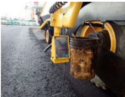
フィニッシャーによる段差摺り合わせ
