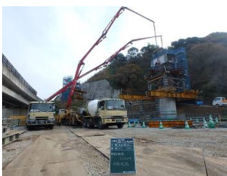
4) 剛結部打設状況
