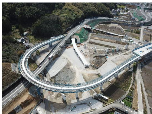
写真-1 完成写真
