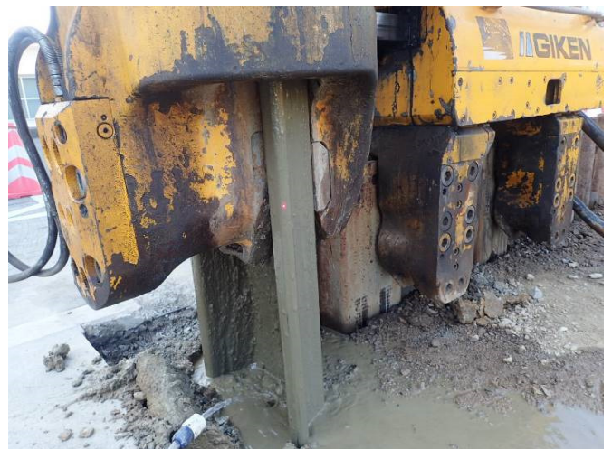
サイレントパイラーによる矢板打設(騒音対策)
