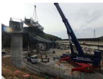
5) 主桁架設状況
