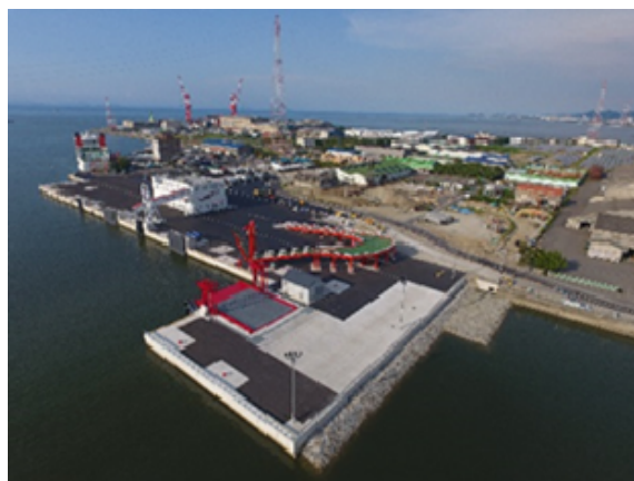
供用開始した東予港中央地区新岸壁
