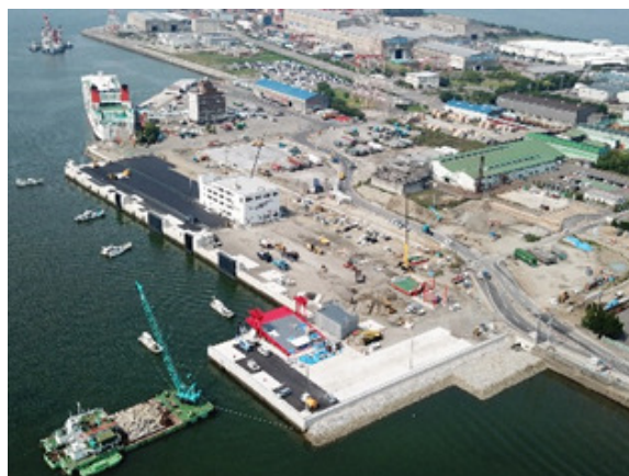
東予港中央地区(工事が輻輳する現場)
