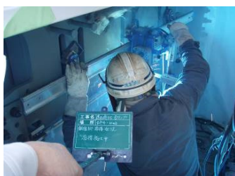
2) 剛結部溶接状況
