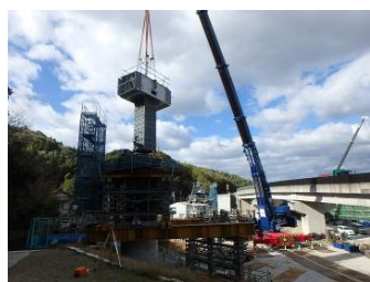
3) 剛結部架設状況
