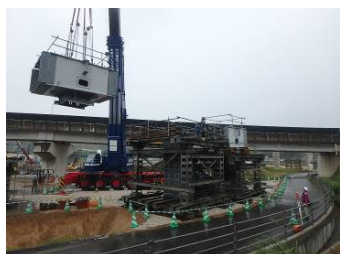
1) 剛結部地組立状況
