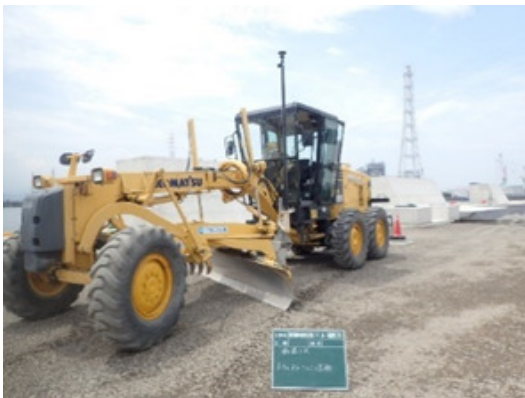
モーターグレーダーによる敷均し
