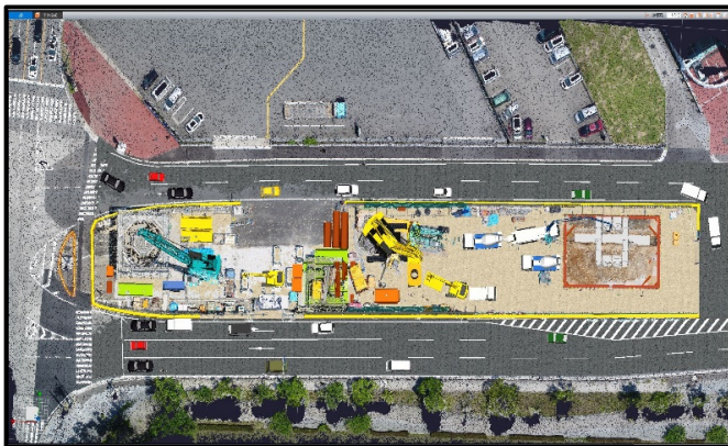
施工モニターによる打合せ(3D)
