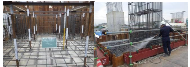
打設高さの見える化 打設面清掃・散水
