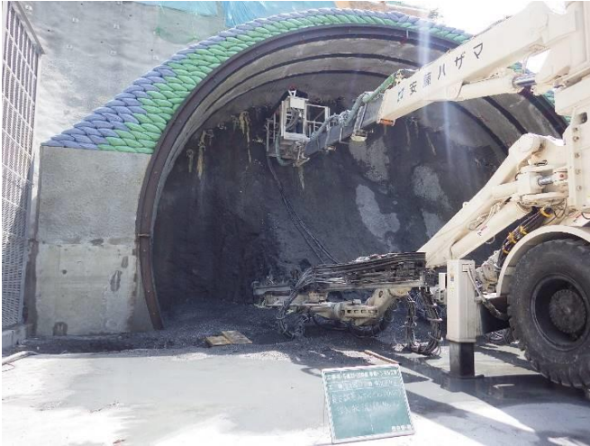
【本坑掘削着手状況】
