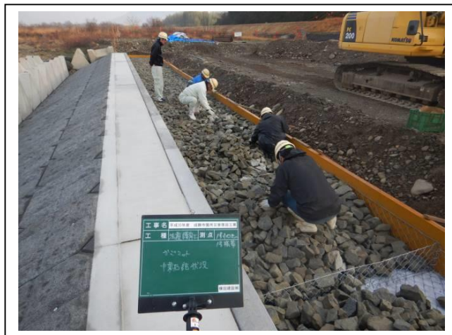
【かごマットへの型枠設置状況】
