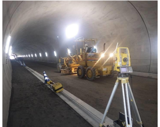
【情報化施工状況】
