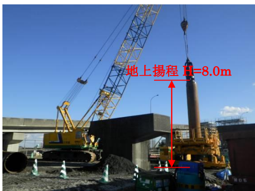
通常作業状況
