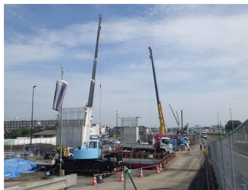
埋設型枠使用時の鋼矢板引抜状況
