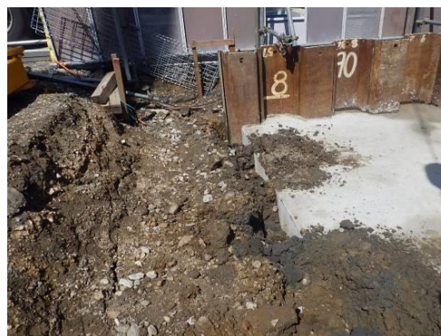
埋設型枠使用時の鋼矢板引抜状況
