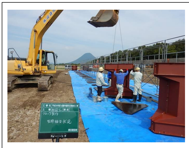
【根固めブロック製作状況】
