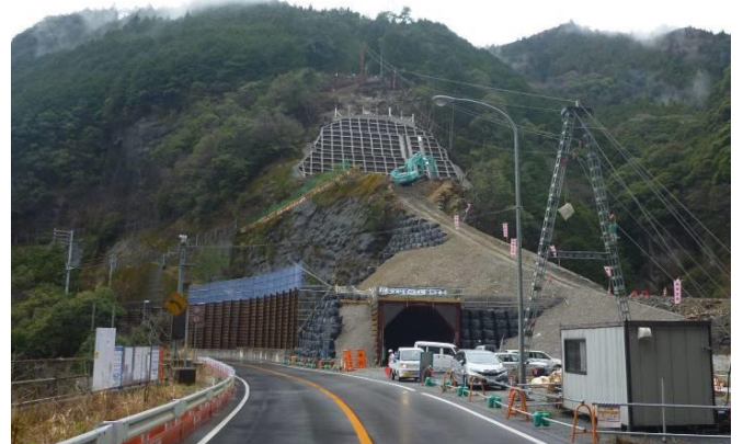
【法面補強工事状況】
