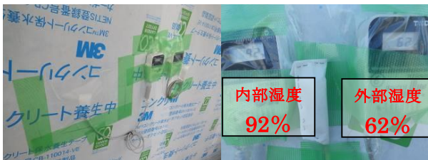
保水養生テープ使用状況
