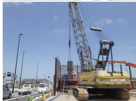
飛散防止柵設置状況
