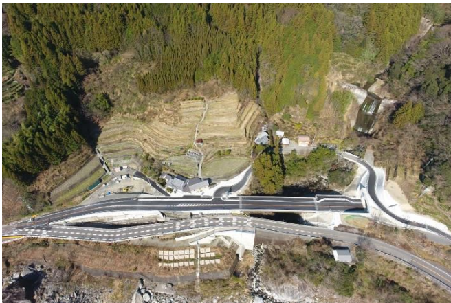
【愛媛側坑口部現況】
