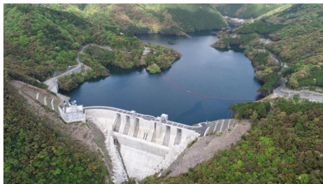
写真-1 横瀬川ダム
