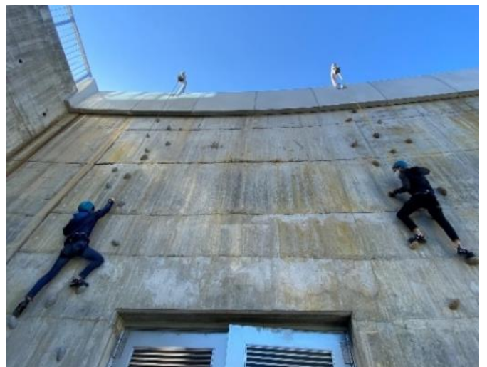
写真-12 横瀬川ダムでのクライミング
