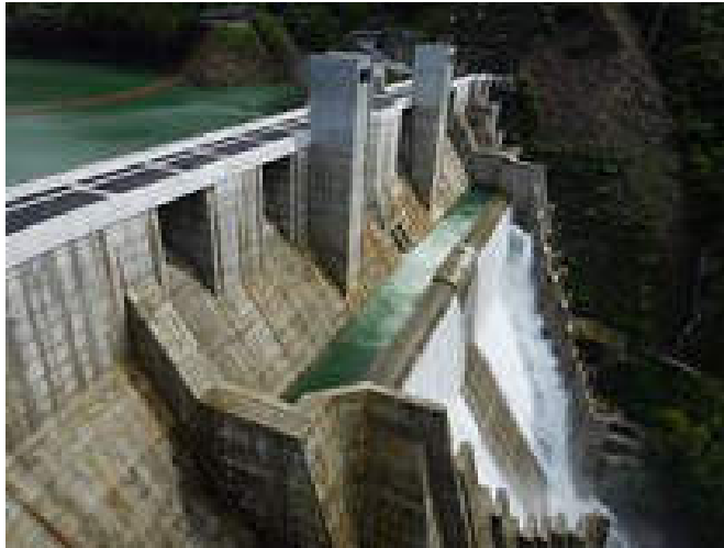
写真-2 側水路減勢方式
