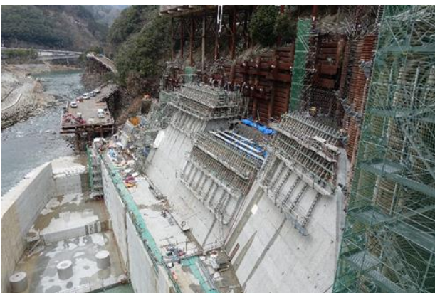
鋼製型枠施工状況
