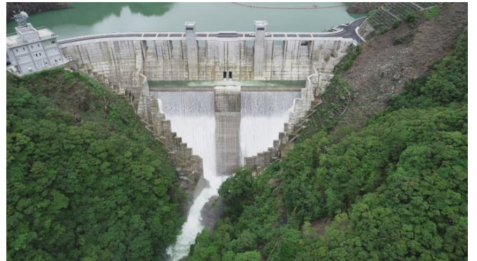
写真-11 側水路からの越流 (R2.7.8 撮影)
