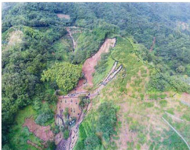
法花津地区 災害時
