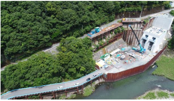
減勢工掘削前状況
