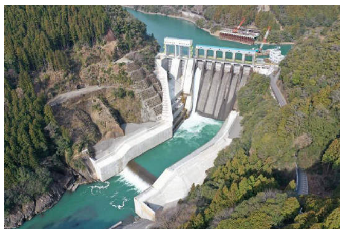
【工事完了全景】
