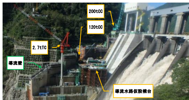
【導流壁の施工状況】
