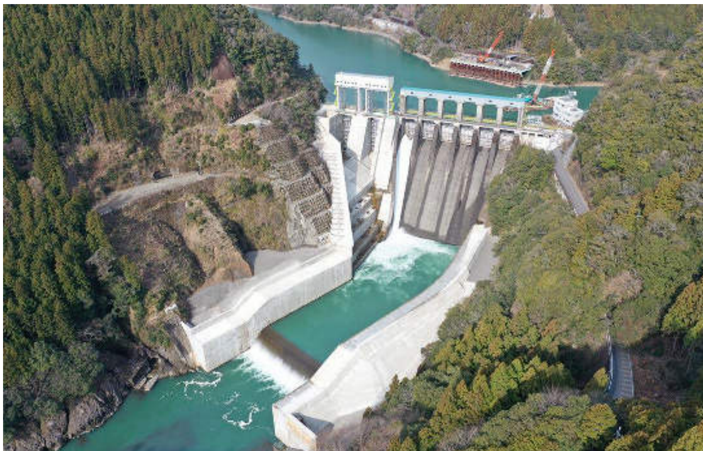
改造事業が完了した長安口ダム：写真提供 鹿島建設㈱
