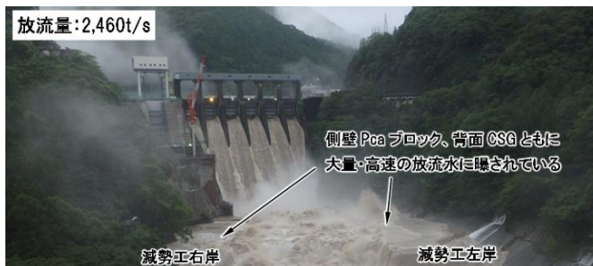
【完成前出水期の放流状況】
