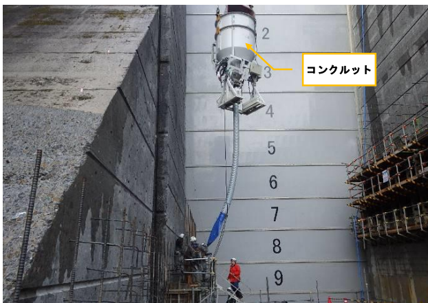
【堤体切削側面部の打設状況】
