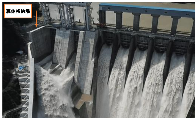
【施工中の扉体格納場】
