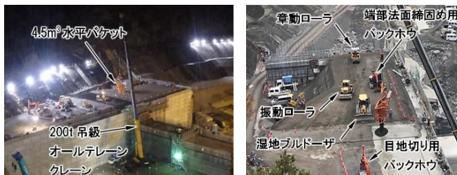
【CSGの製造～打設の状況】
