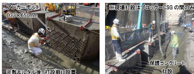
【PCaの据付～保護コンクリート打設の状況】
