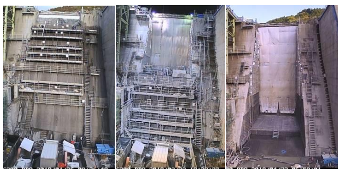
【新設洪水吐(山側)のタイムラプス】
