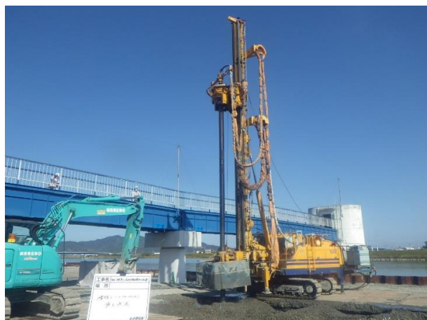
【北ノ川箇所 樋門箇所 地盤改良状況】
