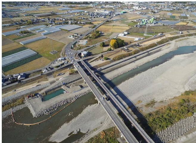
仮設工（締切り盛土・工事用道路）完了全景
