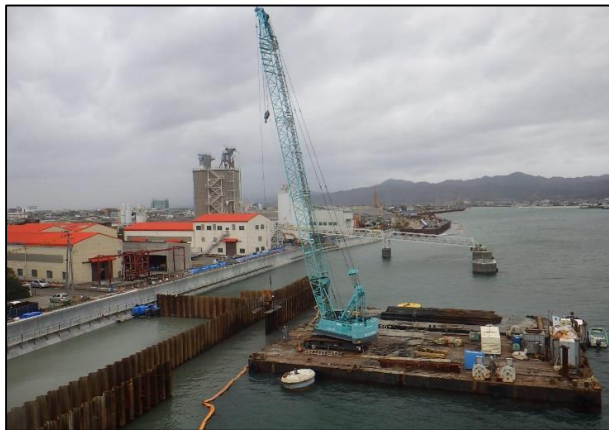
【北ノ川箇所 樋門箇所 地盤改良状況】
