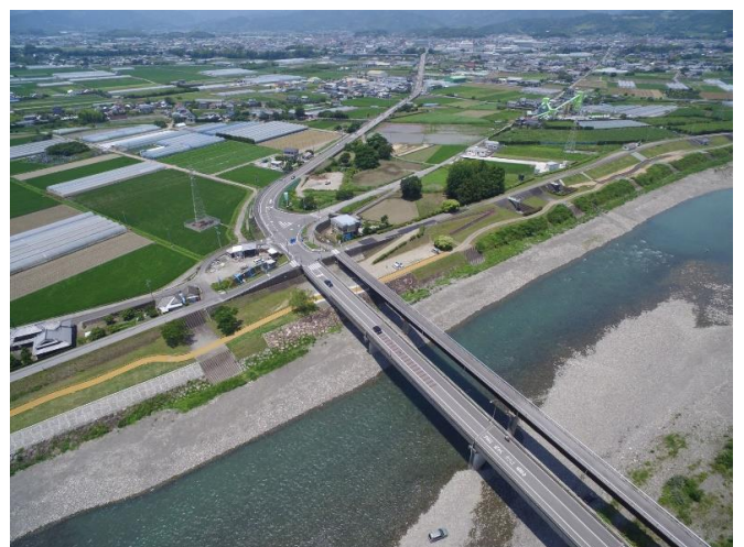
工事完了全景
