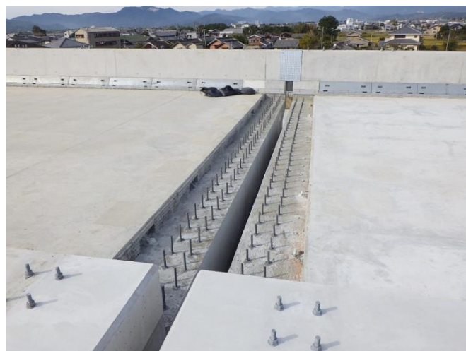
【伸縮装置施工箇所養生前】
