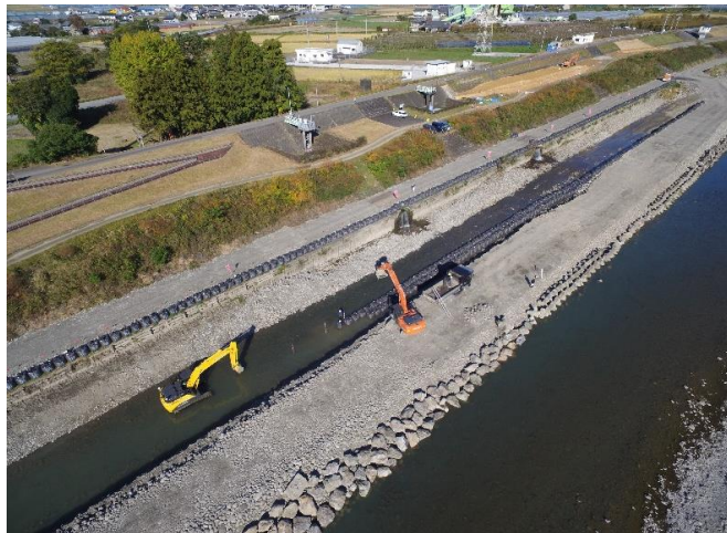
ICT建機による施工状況
