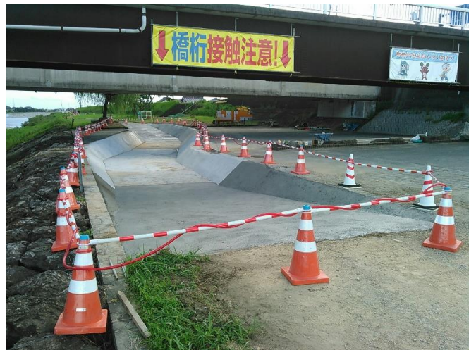
3Dモデルに基づいた工事用道路設置状況
