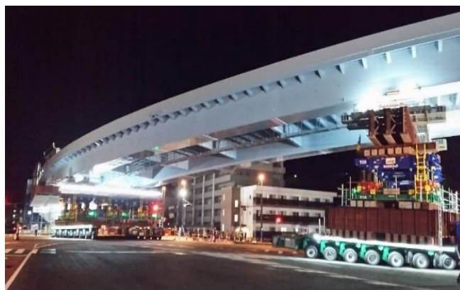
写真4:TD-2702 橋梁一括仮設工事
