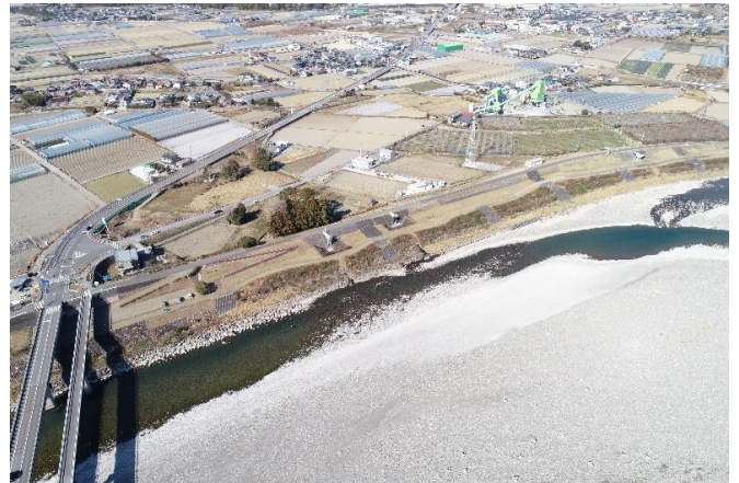
被災箇所の全景
