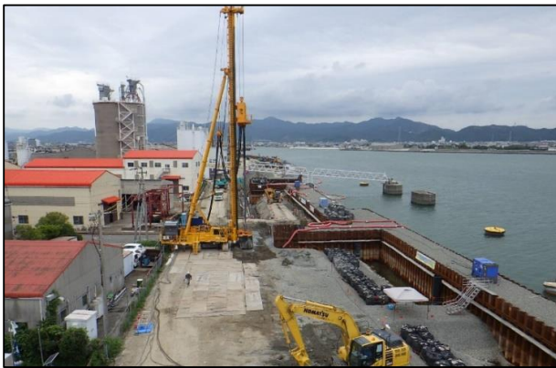
【仮設工 鋼矢板 水上施工】
