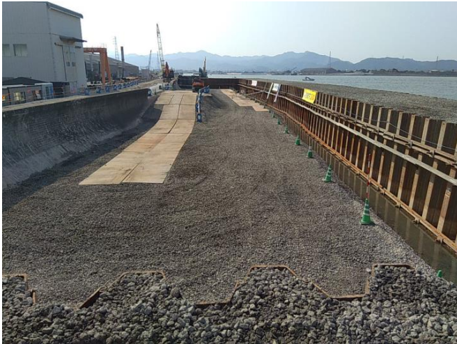
二重仮締切設置状況
