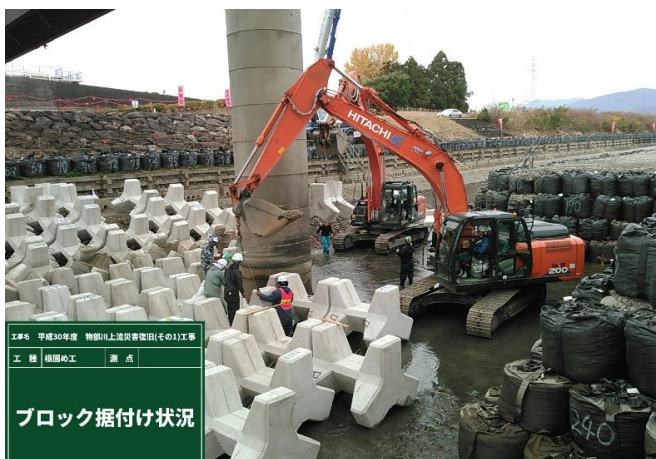
工法変更による橋梁桁下での施工状況
