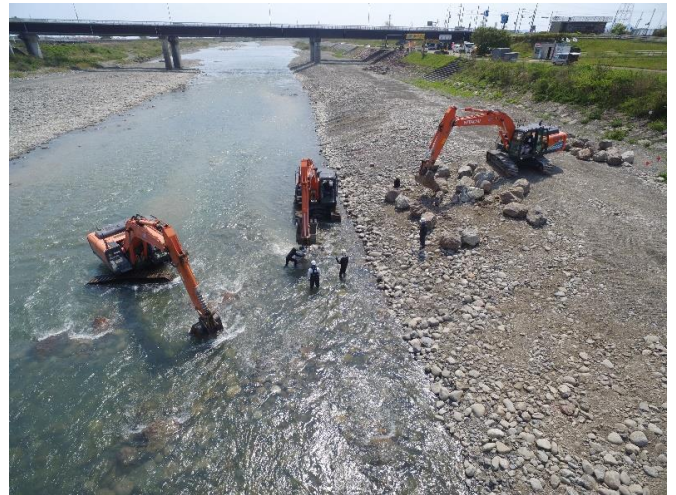
現地巨石・玉石による瀬の造成状況
