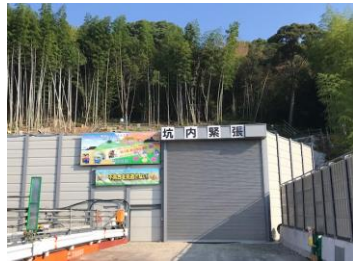
写真 7 坑口部防音壁
