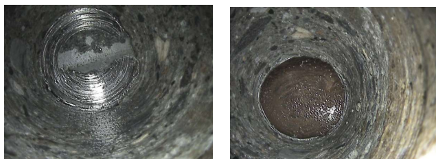
写真 - 7 シース開削状況 (開削前、開削後)
