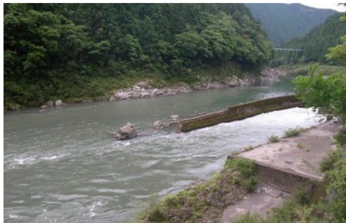
写真6 選択取水設備運用前の濁水時における放流水 (撮影日：平成25年6月5日)
