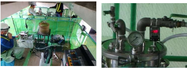
写真 - 11 グラウト再充填状況
