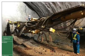
写真4 削孔検層状況
