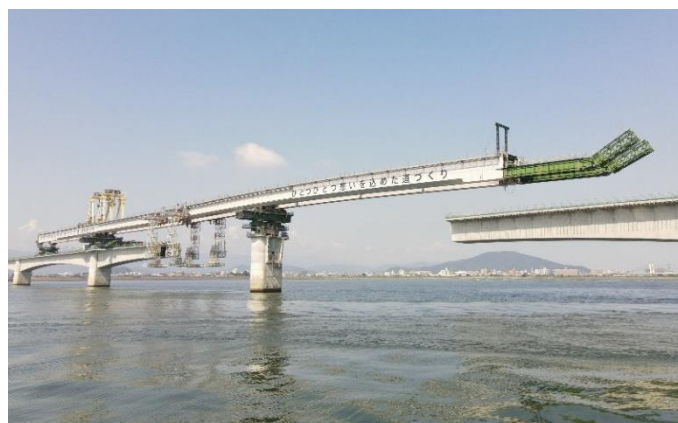
写真-4 上部工の施工状況（架設桁架設）
