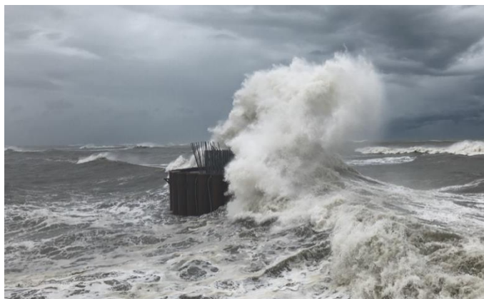
写真-5 強風時の波浪状況（下部工施工時）
