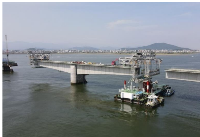
写真-3 上部工の施工状況（エレクションノーズ架設）
