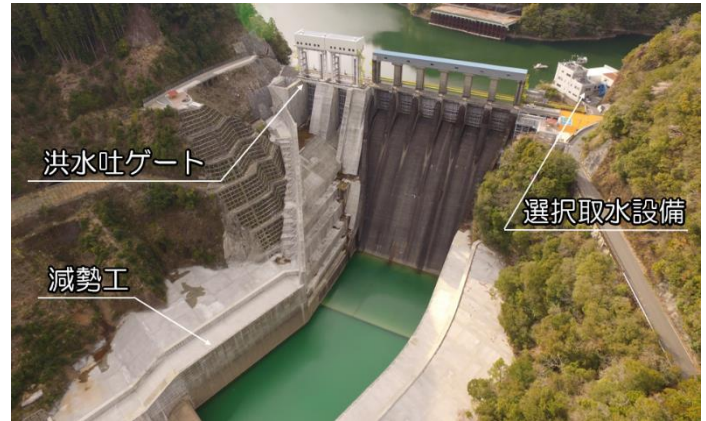
写真 1 長安口ダム本体改造工事概要
