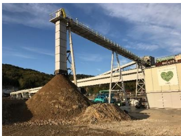
写真 9 ベルトコン落とし口
