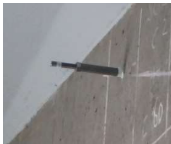
写真 - 8 パッカー設置
