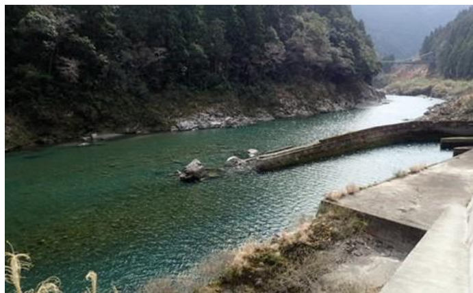
写真7 選択取水設備運用後の濁水時における放流水 (撮影日：令和4年3月17日)
