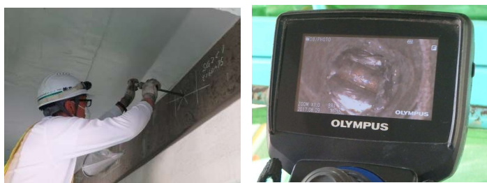
写真-3 シース開削・グラウト充填状況の確認
