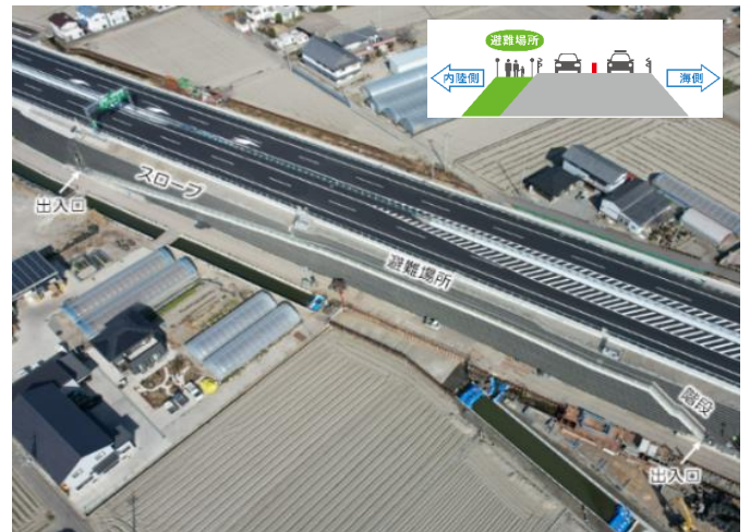
写真-6 津波一時避難場所
