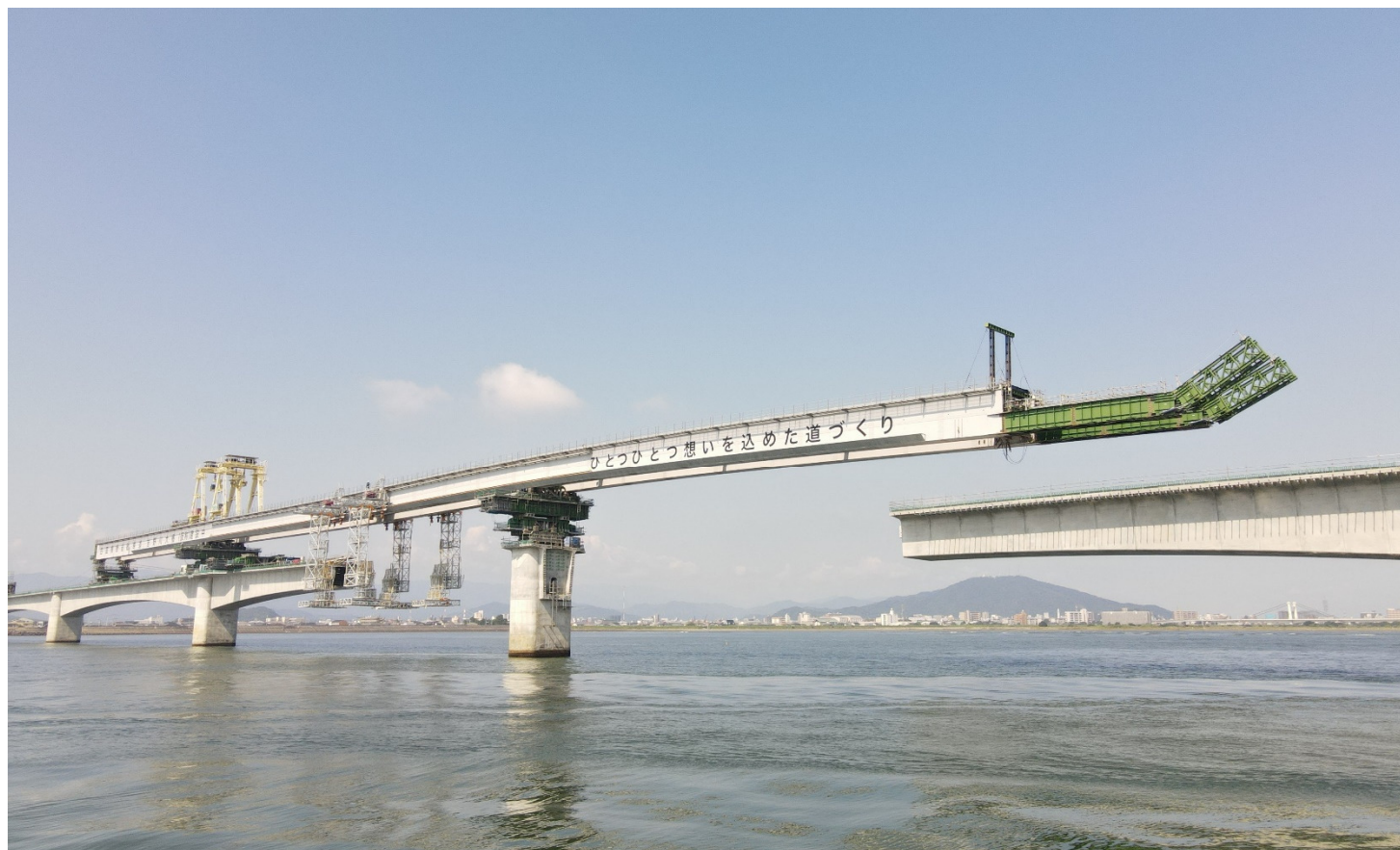
吉野川サンライズ大橋の施工：写真提供 西日本高速道路株式会社
