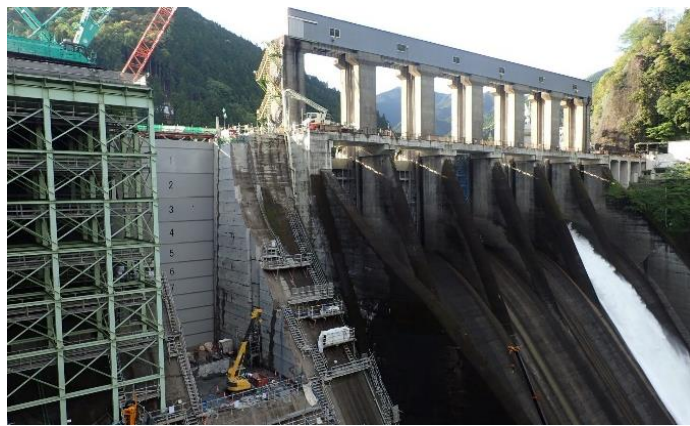
写真2 ダムの運用管理を行いながらの堤体切削
