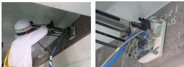
写真-2 PC-Re v工法（削孔状況）
