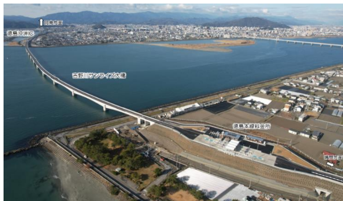
写真-2 一級河川吉野川（吉野川サンライズ大橋）
