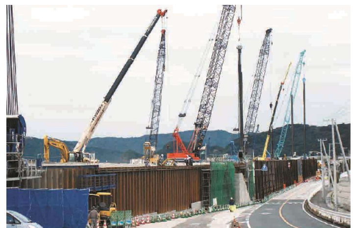
写真3 新居工区 鋼矢板打設の状況
