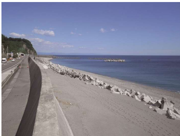
写真4 仁ノ工区 工事対策前
