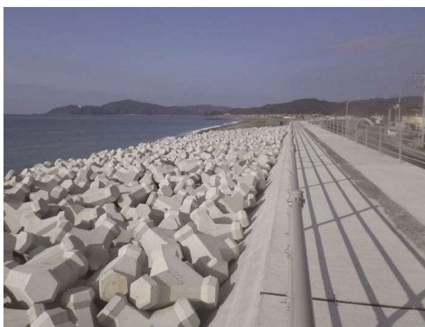
写真5 仁ノ工区 工事対策後
