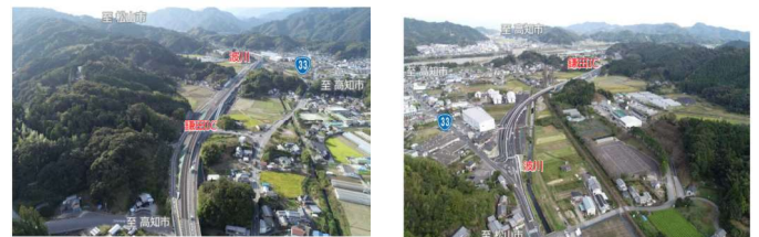
工事完了全景
