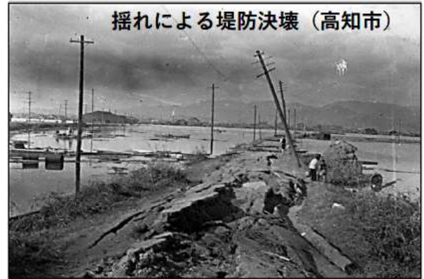
写真 1 昭和南海地震（1946 年）の被害状況
