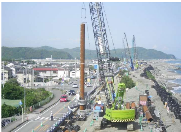
写真2 戸原工区 鋼管杭打設の状況
