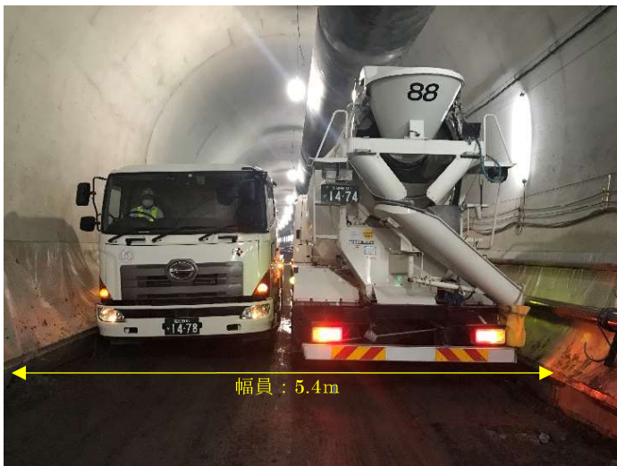
写真-1 離合状況
