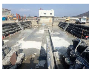
取壊し完了全景
