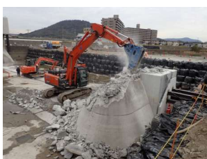
既設堰柱取壊し状況
