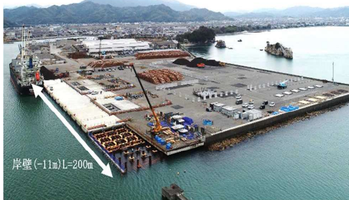
【金磯地区岸壁 (-11m) (提供：四国地方整備局)】
