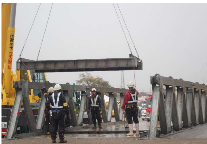
写真5 応急組立橋の設置訓練
