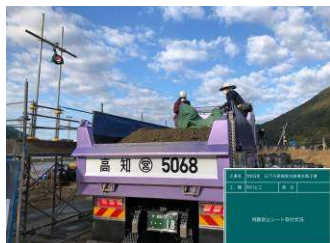
シート掛け状況
