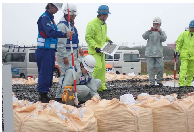
写真6 TEC-FORCE 隊員による破堤箇所調査
