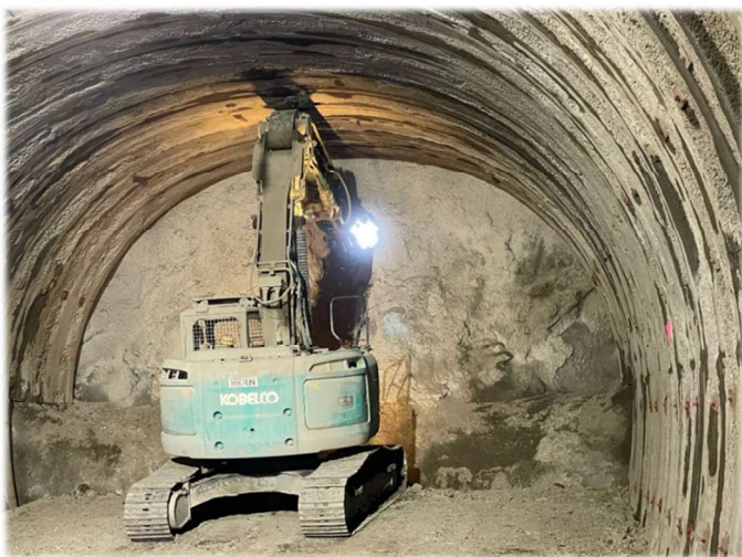
写真3 横島トンネル貫通
