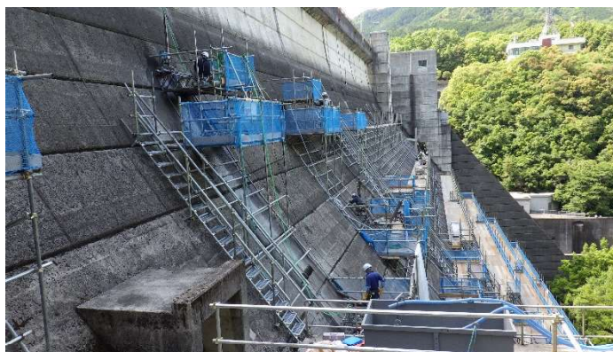
画像－8 ダム天端仮設構台施工状況
