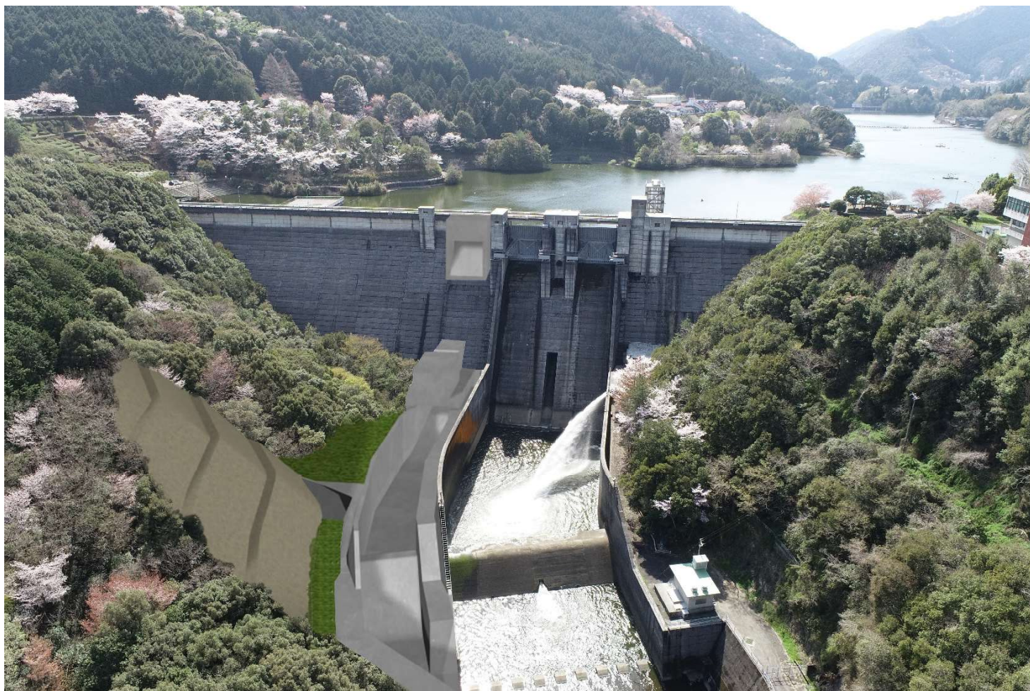
野村ダム改良事業完成予想図：写真提供 四国地方整備局
