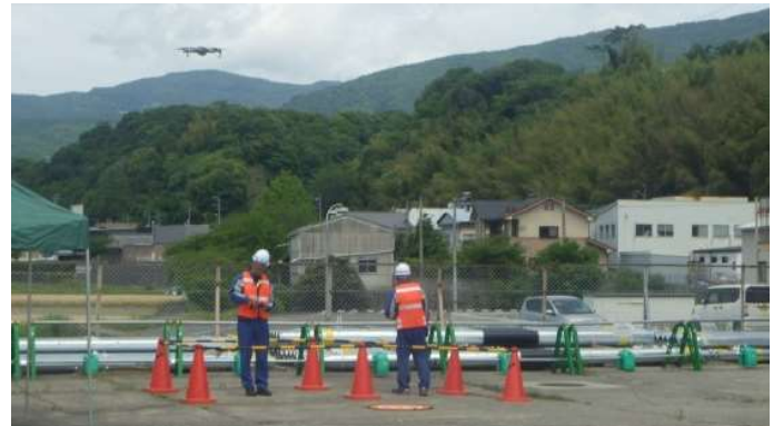
写真13 N T T西日本によるライフライン被災状況調査
