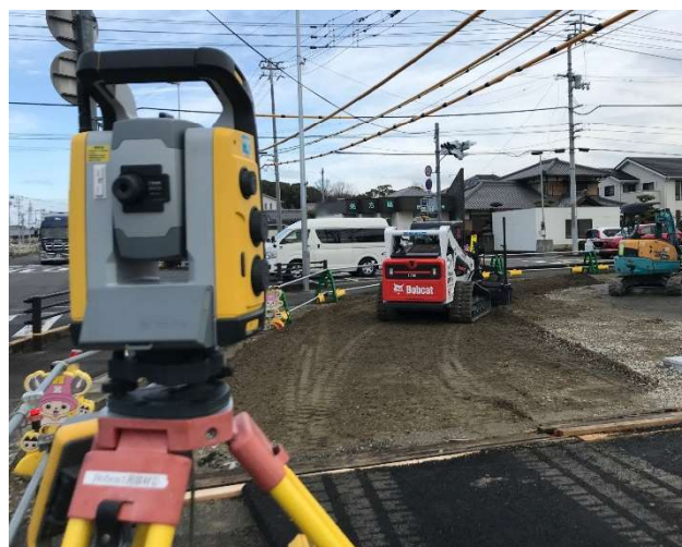
Fig3.小規模現場での ICT 施工風景
