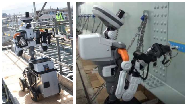
出来形測量検査状況
