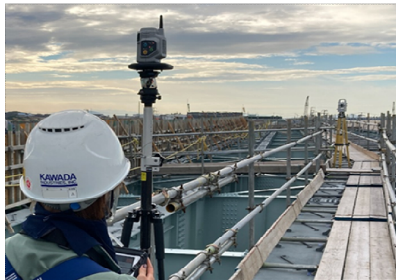
写真-1 ワンマン測量実施状況
