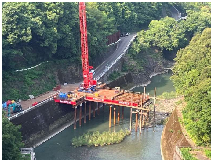
画像－7 渡河橋施工状況
