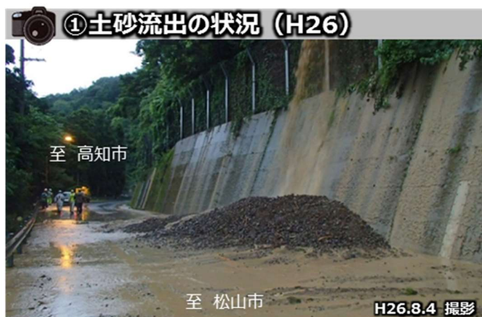
写真6 土砂流出の状況(H26)
