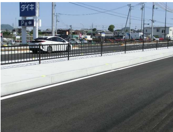
写真4 横断防止柵・平張コンクリート設置状況
