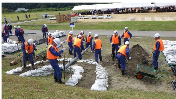
写真4 消防団による水防活動（月の輪工）
