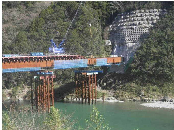
写真4 立花大橋の施工状況
