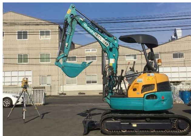
Fig6.ミニ BH 排土板ガイダンス 一般的な排土板付きバックホウへプリズム、モニター兼用 PC を装着し、自動追尾 TS を使用し誘導するものです
