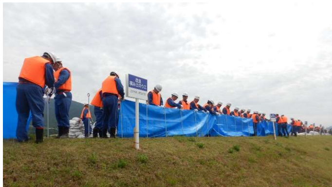
写真5 消防団による水防活動（改良積み土のう工）
