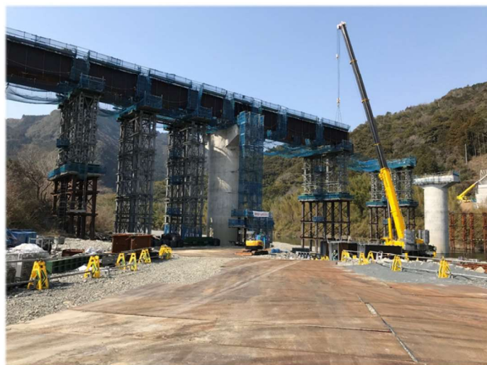
写真5 横倉大橋の施工状況
