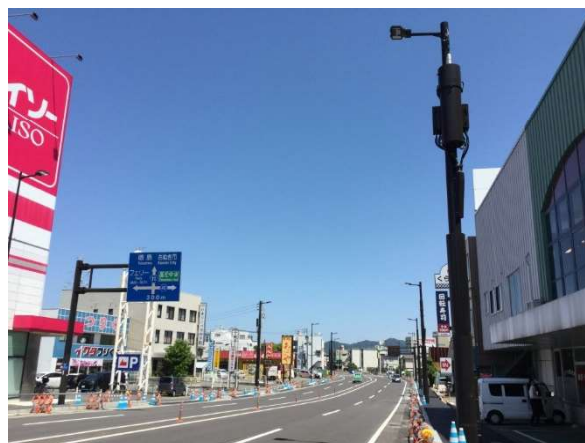
写真4 無電柱化後の状況（他地区）
