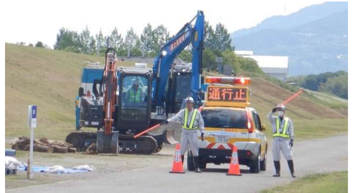
写真12 徳島県建設業協会と四国地整による道路啓開訓練
