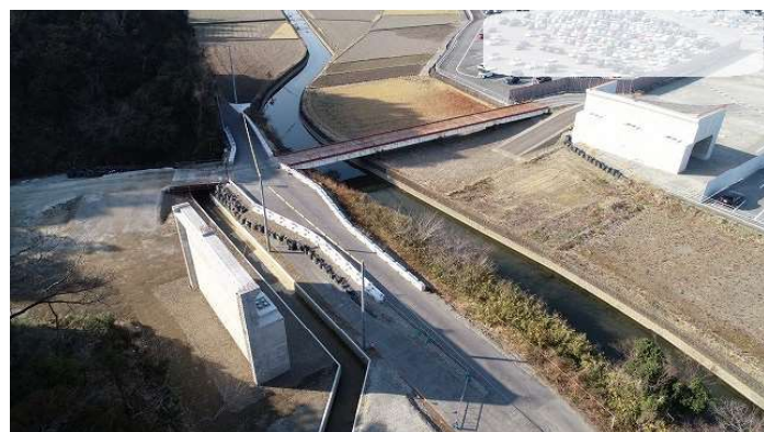
完成写真 ※左側A2橋台
