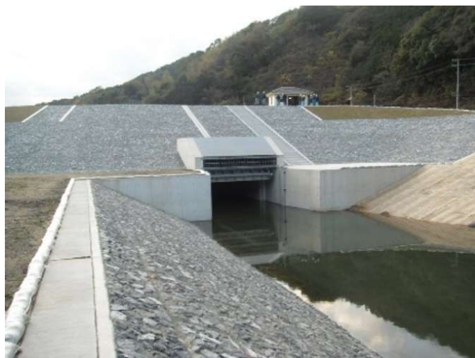
写真-5 奥谷川樋門
