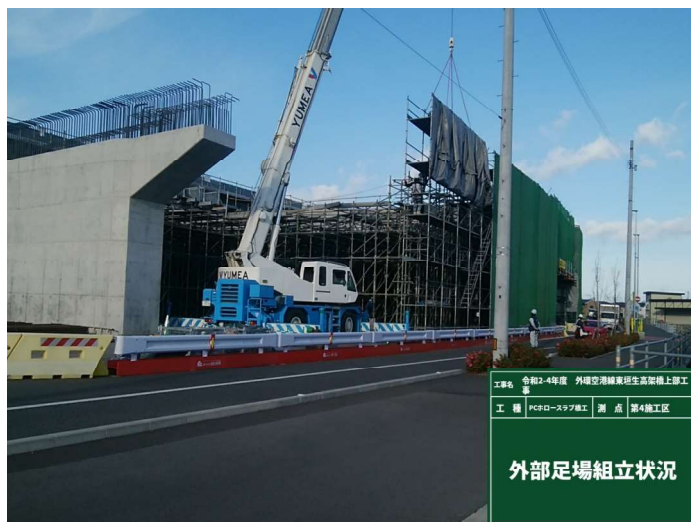
ブロック組による足場組立状況
