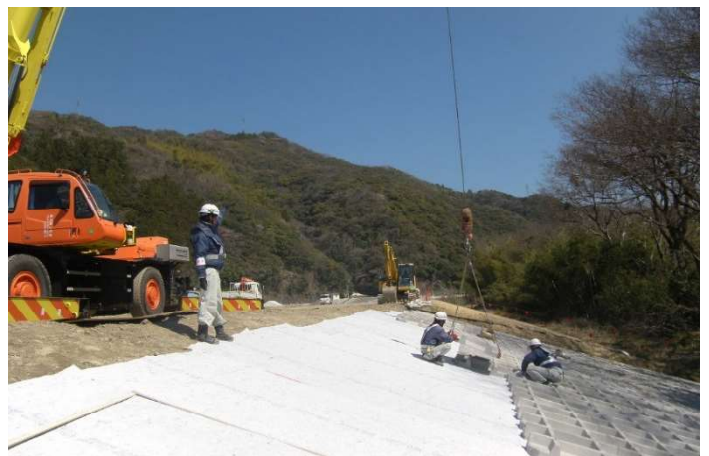
写真-4 施工状況
