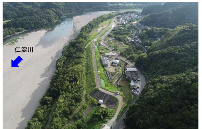
写真-7 仁淀川加田堤防
