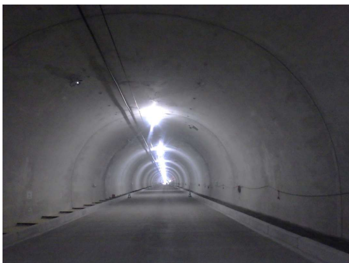
写真-2 トンネル完成
