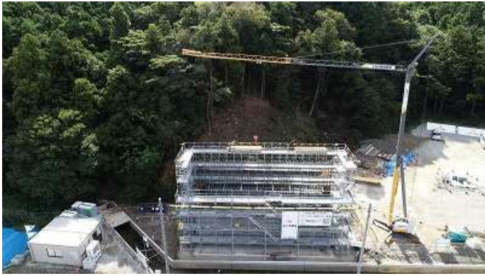
定置式水平ジブクレーン使用による資材吊込み状況
