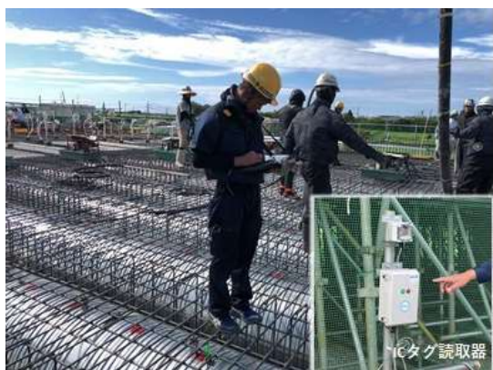
タブレットによる打重ね時間管理状況
