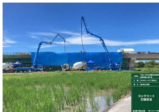
コンクリート打設状況
