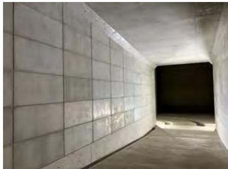
写真-7 CO<sub>2</sub> 吸収型埋設型枠 完成
