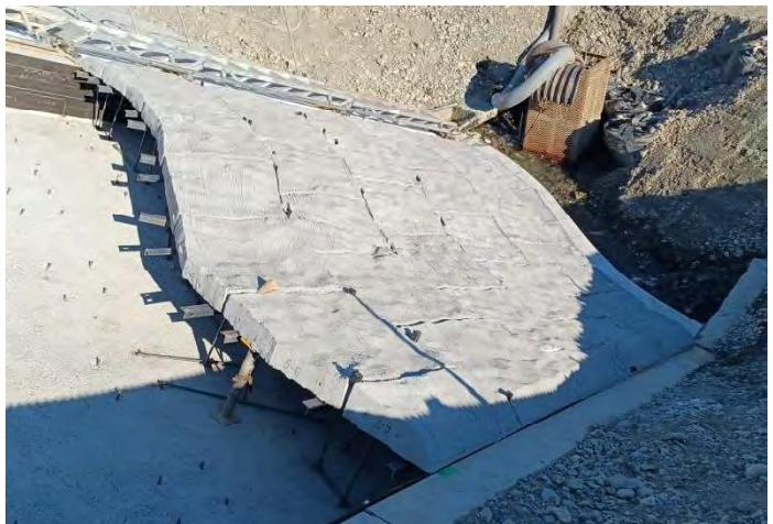
【擬石型曲線護岸パネルの設置状況】
