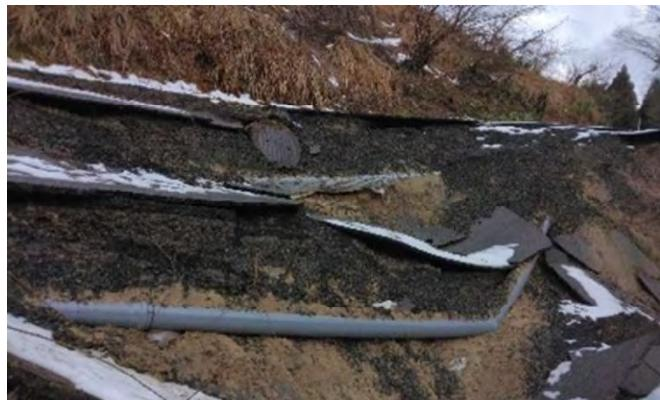
浄水場から配水池へ向かう水道管の破損・露出（輪島市）
