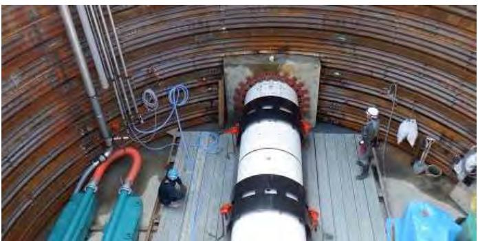
シールド工法による基幹管路の耐震化事業（高知市）
