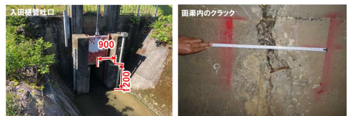
図-4 入田樋管の状況
