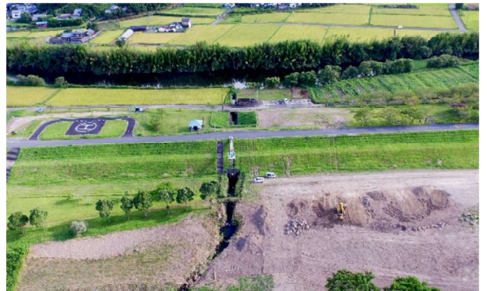
図-3 入田樋管周辺の状況
