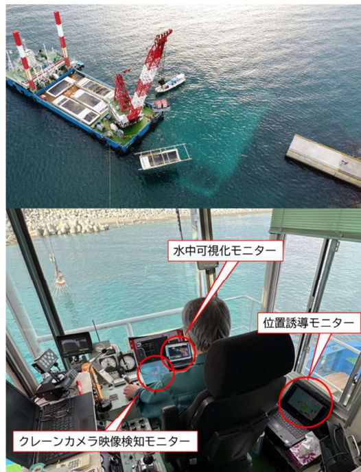
マット敷設状況およびクレーン操作室内
