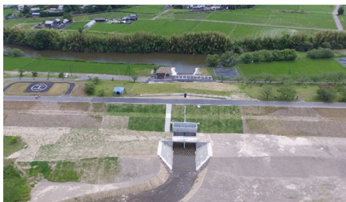
図-3 完成した入田樋門周辺の状況
