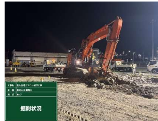
(大型バックホウ掘削)
