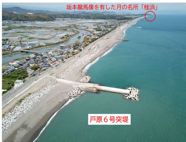
工事完成状況（西方から東方を望む）
