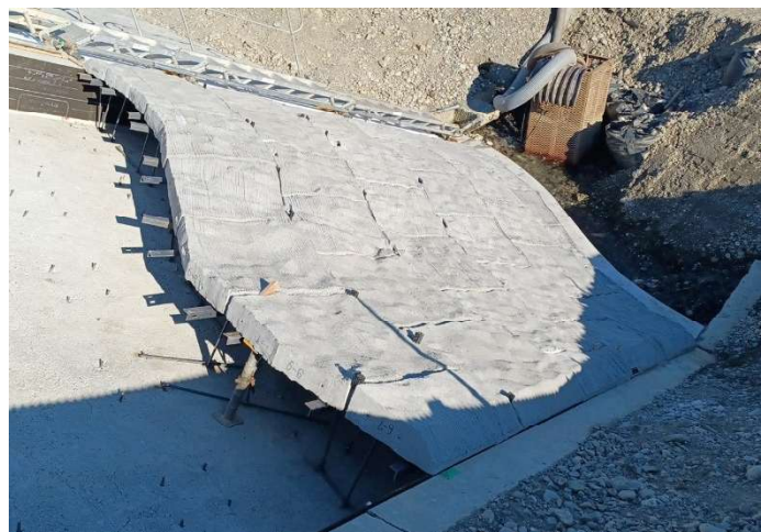
【擬石型曲線護岸パネルの設置状況】
