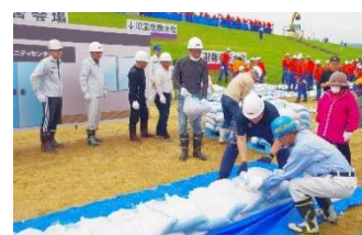
自主防・高校生による 改良積み土の工法II型
