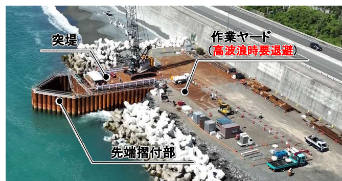
図-3 現地の施工状況
