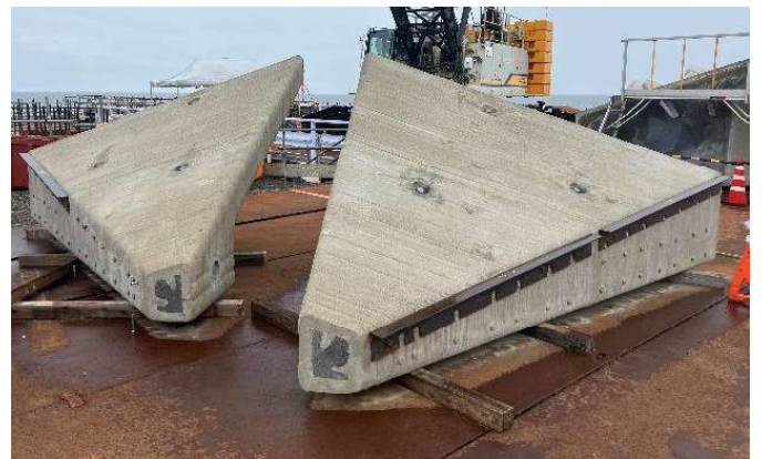
写真-3 先端擦付部ブロックの現場搬入
