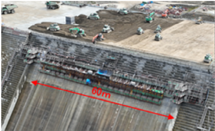
写真-4 自動スライド型枠運用範囲
