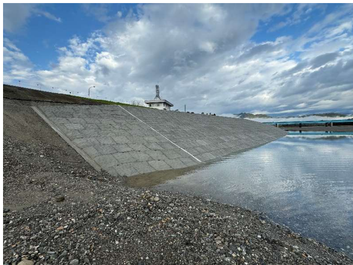
【擬石型曲線護岸の完成】
