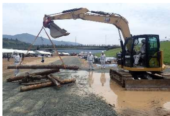
愛媛県建設業協会による 道路啓開訓練
