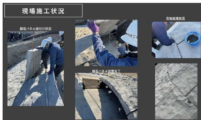
【施工状況ダイジェスト】
