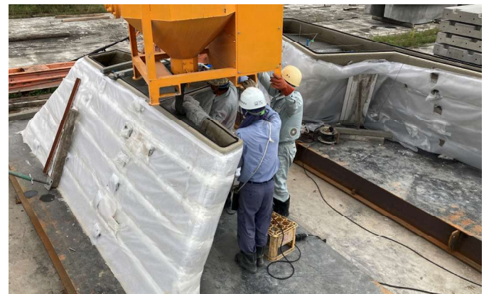
写真-2 外殻内部への常温硬化型 UFC 打設
