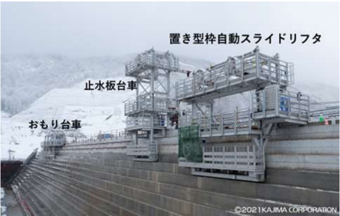
写真-3 堤体上下流面で稼働する各台車
