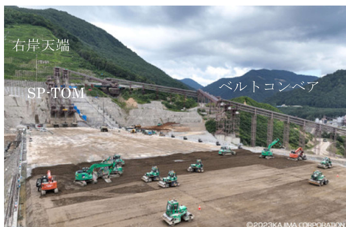
写真-1 自動化施工全景
